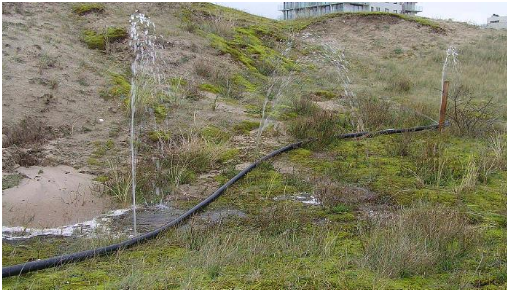
Oppervlakte-infiltratie van bemalingswater in het duingebied in De Panne voor het project “rusthuis Duinenzee” (met dank aan AGT)
