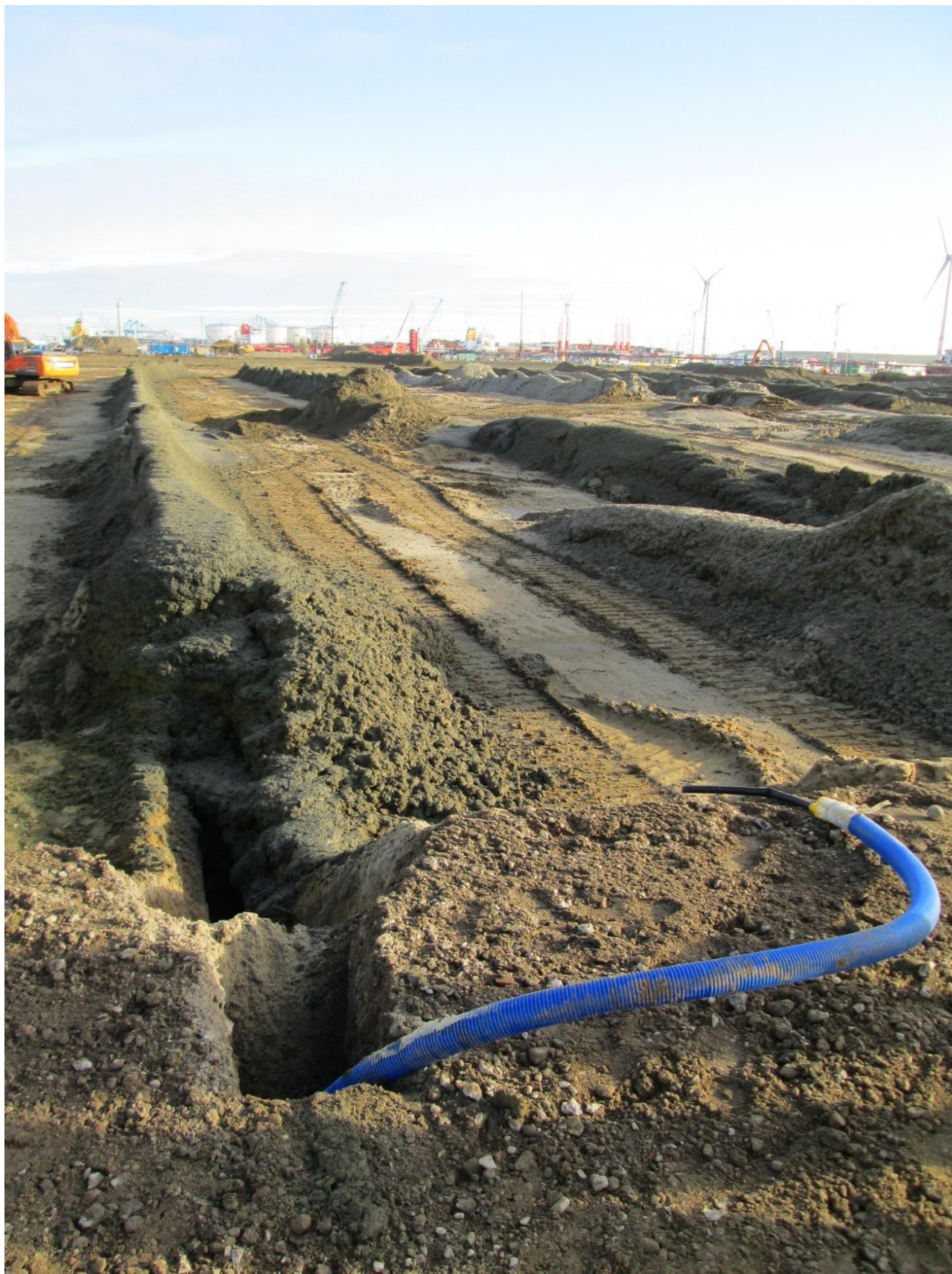
Blind gedeelte van de draineerbuis na de freesoperatie – dit gedeelte blijft boven de grond zelfs na uitgraving van de sleuf en wordt aan de afvoer- of hoofdleiding verbonden
