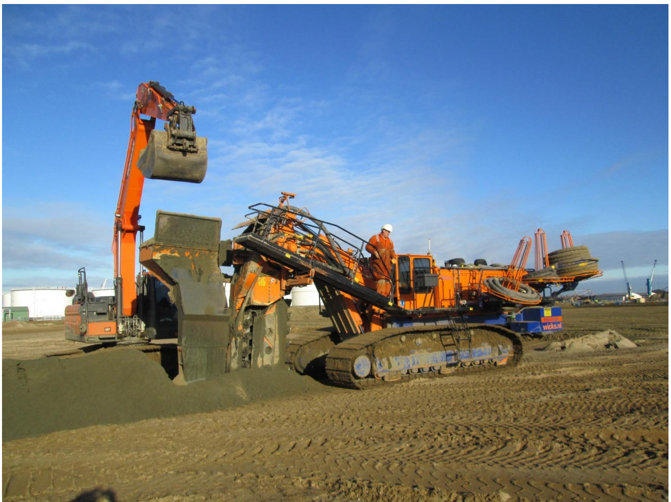
Plaatsing van een horizontale drainage met het gebruik van een speciale draineermachine
