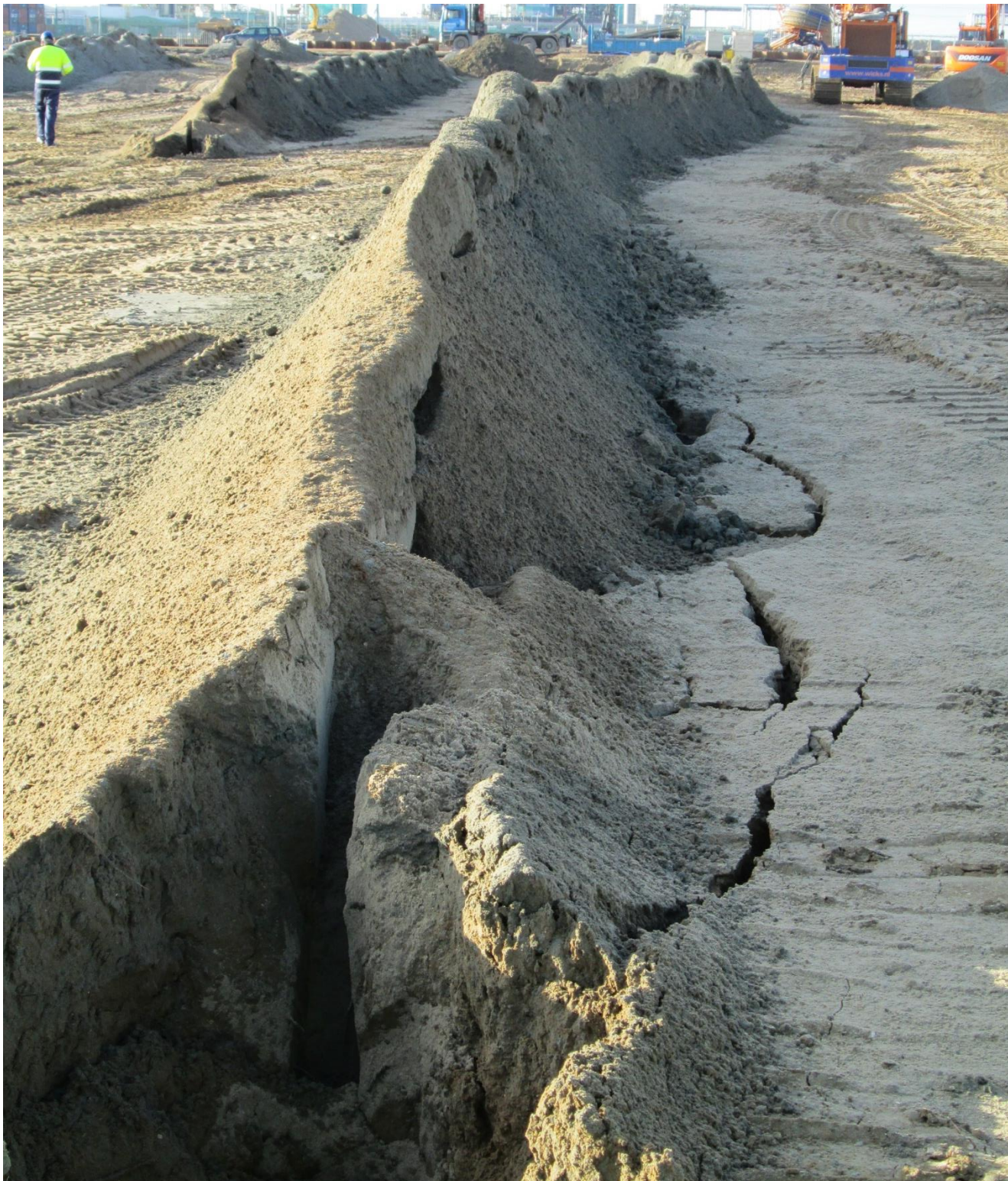
Grondontspanning langsheen de drainlengte veroorzaakt door het infrezen van de drainsleuf
