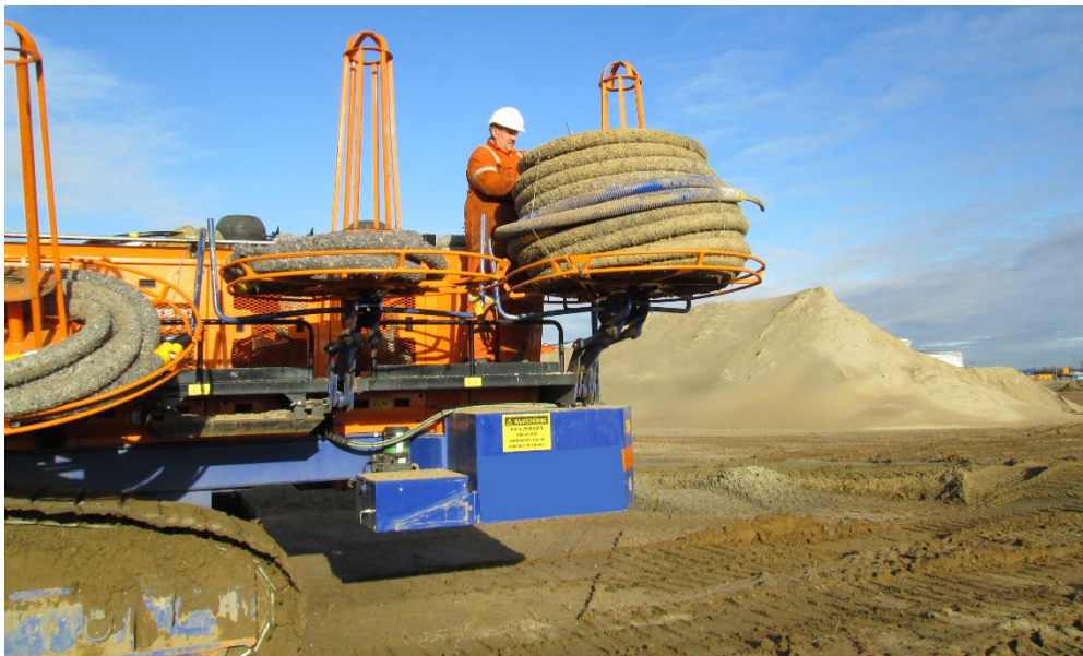
Positionering van de haspel met de draineerbuis op de kettinggraafmachine
