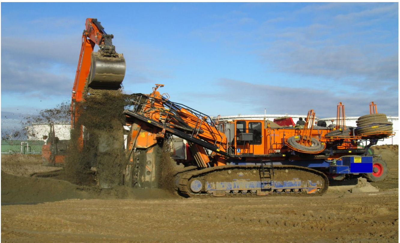
Aanvullen van de uitgegraven sleuf met draineerzand
