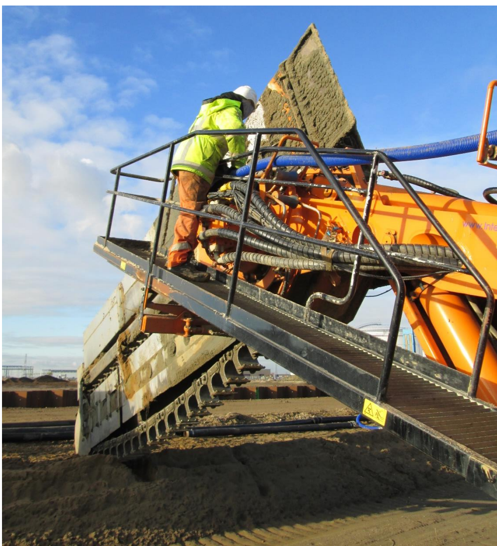
Positionering van de draineerbuis in de speciale koker/boom vóór de start van de realisatie van de sleuf
