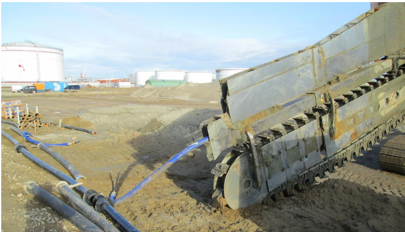
Het blinde gedeelte van de draineerbuis voor het begin van de freesoperatie – dit gedeelte blijft boven de grond zelfs na realisatie van de sleuf en wordt aan de afvoer- of hoofdleiding verbonden
