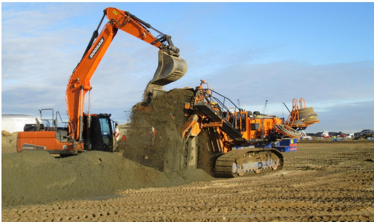
Uitvoering van de sleuf en aanvullen van de uitgegraven sleuf met draineerzand via een zandtrechter
