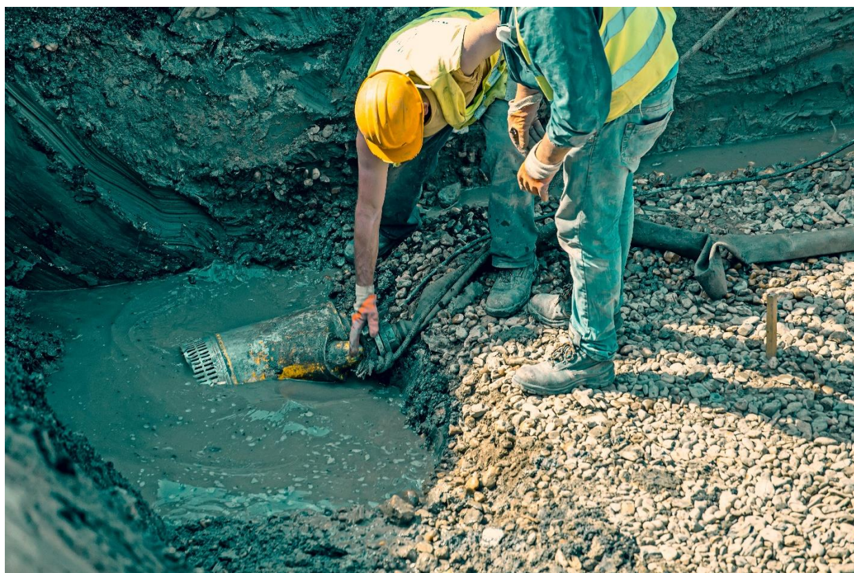
Dompelpomp neergelegd op een grindpakket in de pompput
