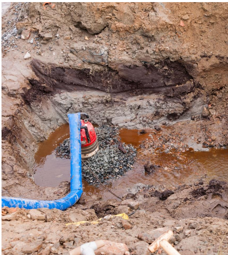
Dompelpomp neergelegd op een grindpakket in de pompput
