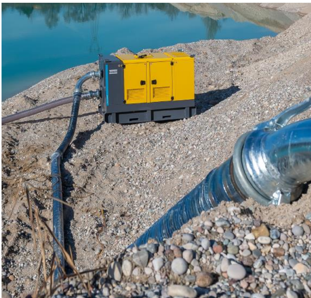
Typische oppervlaktepomp met een zuigslang neergelegd in de verzamelput van de bouwput (met dank aan Atlas Copco)
