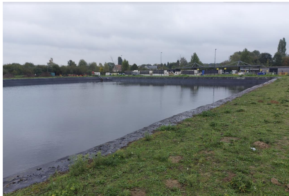
Hemelwaterput Groendienst Neerland
