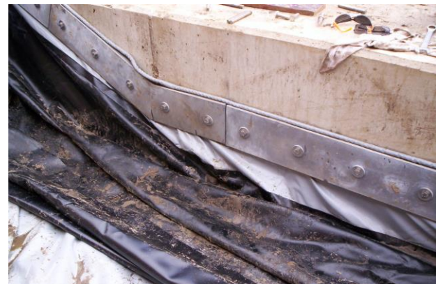
• Aansluiting op beton met RVS strip
