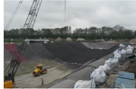
• Aanbrengen ballastlaag
