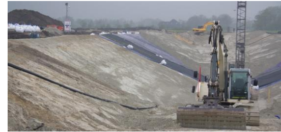
• Aanbrengen ballastlaag
